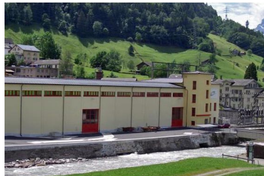
Sauberes Wasser fließt aus den Turbinenanlagen der SN Energie Schwanden und soll, statt zurück in den Fluss, direkt unterirdisch einem neuen Kraftwerk zugeleitet werden (Bild: Impulsteam, Kaspar Glarner und Andreas Bänziger).
