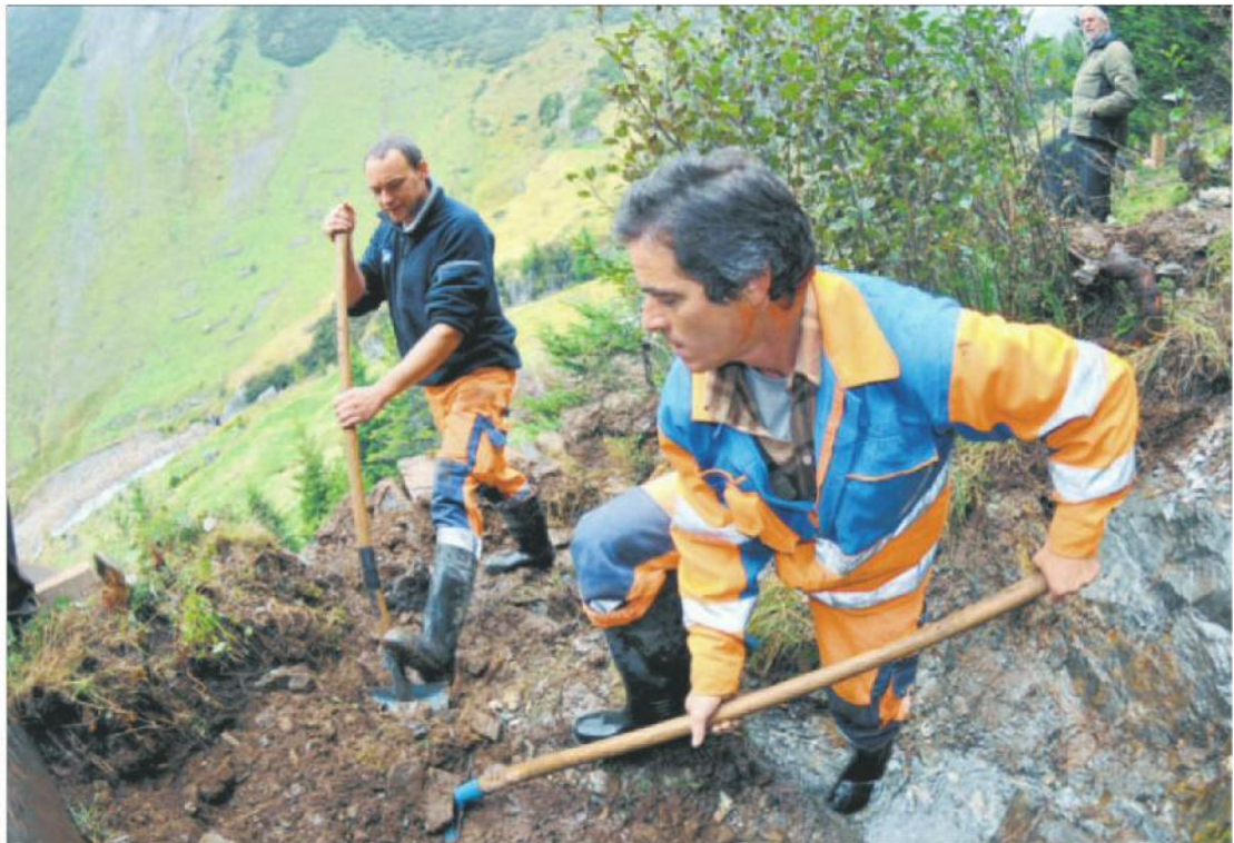
Zurzeit sind die Arbeiter damit beschäftigt, die Quellfassung zu sanieren.
