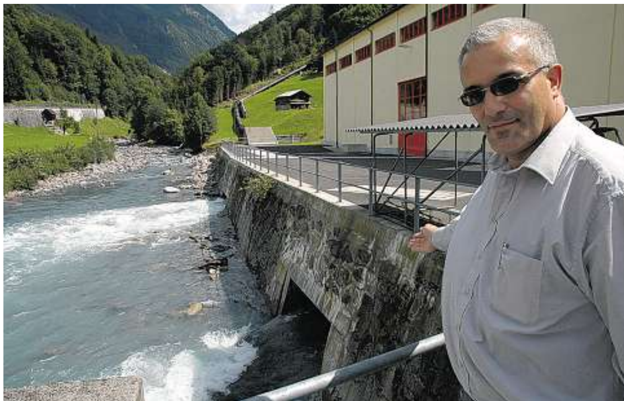
Lösung vor der Tür: Leo Meier zeigt vor der SN-Zentrale in Schwanden die drei Ausläufe von turbiniertem Wasser, das nochmals genutzt werden soll.
